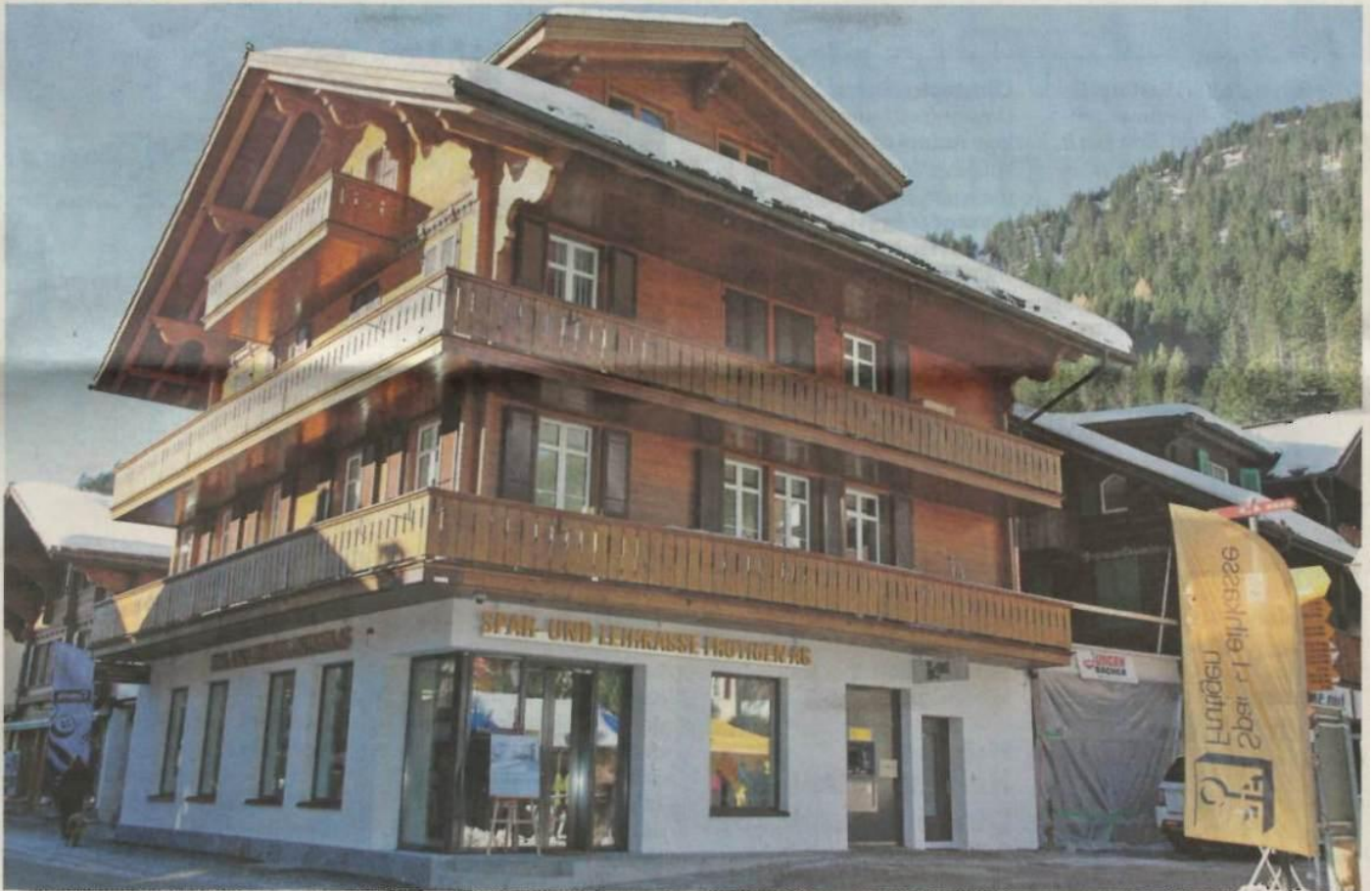
Das umgebaute Adelbodner Agenturgebäude der Spar- und Leihkasse Frutigen AG.
