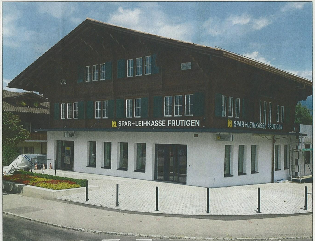
Die Agentur Aeschi wurde im ersten Halbjahr komplett umgebaut.
